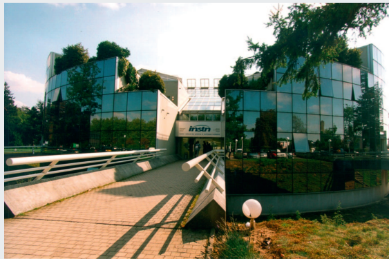
INSTN : vue du nouveau bâtiment adossé à l'ancien.
