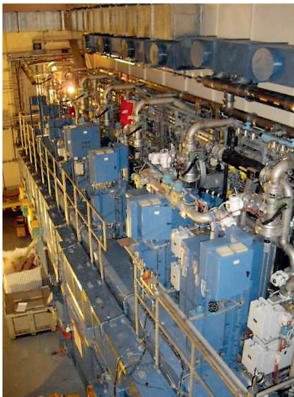
Fig. 4. Le Laboratoire de Haute Activité de Saclay (LHAS), avant démantèlement.
