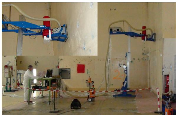
Fig. 105. Démonstration de fonctionnement de l'Aspilaser® à l'Atelier de traitement de l'uranium de Cadarache (décontamination peinture sur béton).
