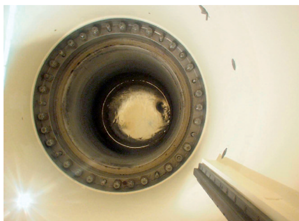
Fig. 23. Le sodium primaire du réacteur PHÉNIX, vu par une traversée de la dalle.
