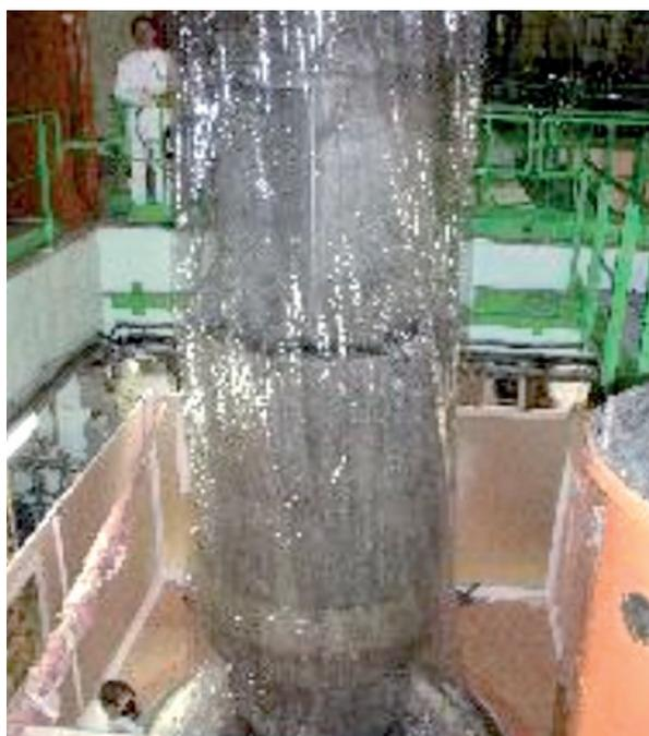
Fig. 100. Manutention d'un échangeur en puits de lavage / décontamination sur PHÉNIX.
