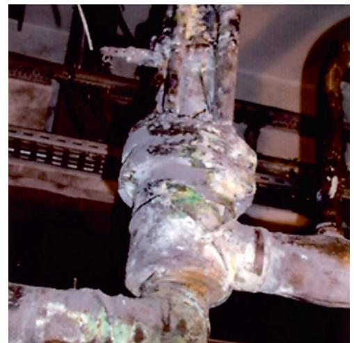
Fig. 94. Vanne décalorifugée après une fuite de sodium sur PHÉNIX.
