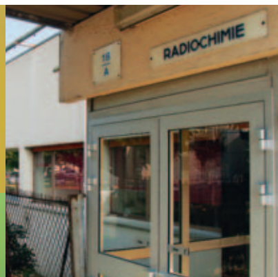
Bâtiment 18 de l'INB 165. © J.-L. Dolmaire/CEA
