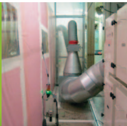
Sas de démantèlement avec confinement dynamique d'un chantier de l'INB 166. © CEA
