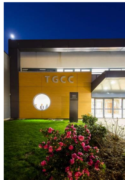
Le Très grand centre de calcul (TGCC sur le site CEA de Bruyères-le-Châtel) ©P.Stroppa/CEA
